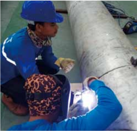
● 現場施工 Work Situation
