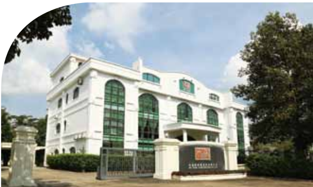
● 公司大門全景 Company entrance overview
