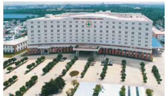
● 震興醫院 Shing Mark Hospital
